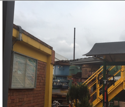
FOTOGRAFIA 4. ASPECTO EXTERIOR DEL DUCTO DE LA CALDERA
